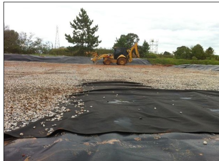
Espalhamento de brita.
