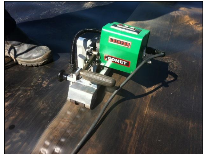
Solda da manta Geomembrana
